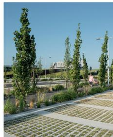
Le **fasce filtranti** sono aree inerbite con una moderata pendenza progettate per trattenere le acque meteoriche.
