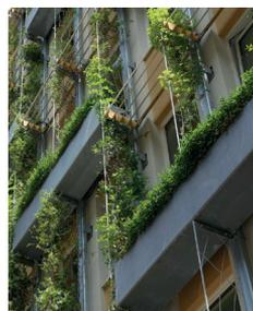
Le **pareti verdi** migliorano il microclima, la qualità dell'aria e la biodiversità. Nel progetto sono state adottate due tipologie di pareti verdi, la prima che ricopre le pareti cieche prevede una vegetazione compatta sostenuta da pannelli che contengono terreno su un telaio. La seconda soluzione, per pareti con aperture prevede piantumazioni di rampicanti radicate dal basso sostenute da elementi a cavo.
