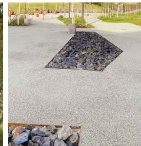
Pozzi di infiltrazione
